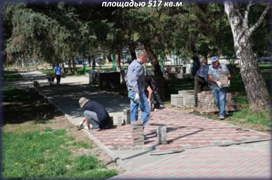
Выполнена работа по замене основания и плиточного покрытия парка ст. Преградной площадью 517 кв.м
